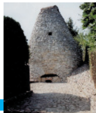
Piec garncarski w Iłży przy ul. Wójtowskiej
