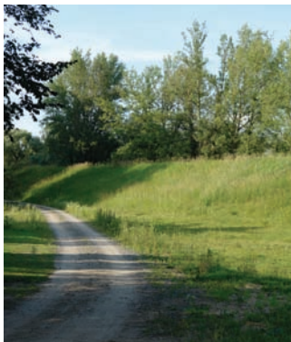
Droga wzdłuż wału przeciwpowodziowego
