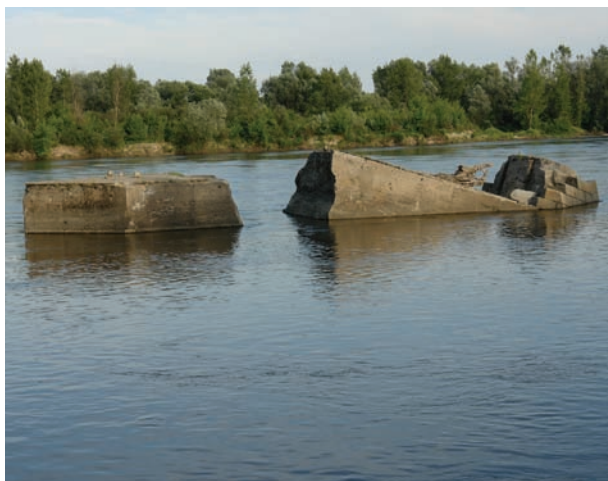
Chotcza Dolna - filary mostu na Wiśle
